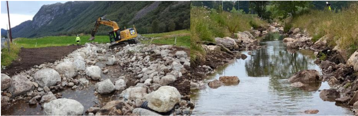
Figur 11. Eksempel på aktuell tiltaksutforming i form av ru steinsetting. Til venstre er strykparti i Frøylandsbekken (Dirdalsvassdraget), til høyre er et roligere parti i Kvernbekken på Klepp (Figgjovassdraget). Foto t.h.: Knut Ståle Eriksen.
