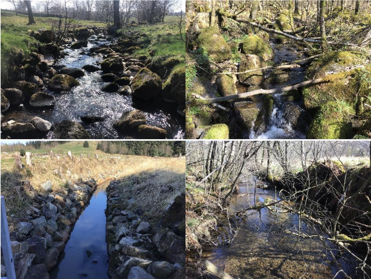
Figur 77. Bilder fra øvre, søndre løp. ØV: Stryk i sone 56. ØH: Et unntaksvis intakt bekkemiljø i form av stryk i sone 60. NV: Fra sone 62 og oppover er bekken i stor grad preget av ulike inngrep og tilslamming, med enkelte unntak. Fra sone 63, glattstrøm med kanalisert løp, erosjonssikrede kanter og manglende kantvegetasjon. I området på bildet gikk bekkeløpet på annet sted enn det inntegnede løpet på kart, så her er løpet trolig flyttet for ikke lenge siden. NH: Et unntak for øvre del av bekken. Lokalt bedre bekkemiljø med gytegrus i sone 77.
