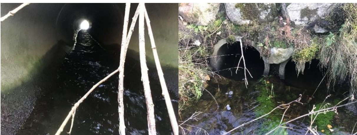
Figur 47. Bekken er lukket ved rørlegging i over 200 meters lengde. Venstre: 25 meter lang rør ved trafostasjon midt i bekken utgjør ingen hindring for fisken. Høyre: Det samme gjelder for de fleste andre rørene også, som disse nær Hinnalandstjørna.
