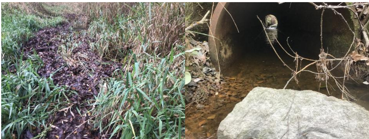
Figur 143. Venstre: Vandringshinder 6, tett vegetasjon. Høyre: Over 200 meter av bekken er lagt i rør, men ingen av disse bekkelukkingene utgjør vandringshindre.
