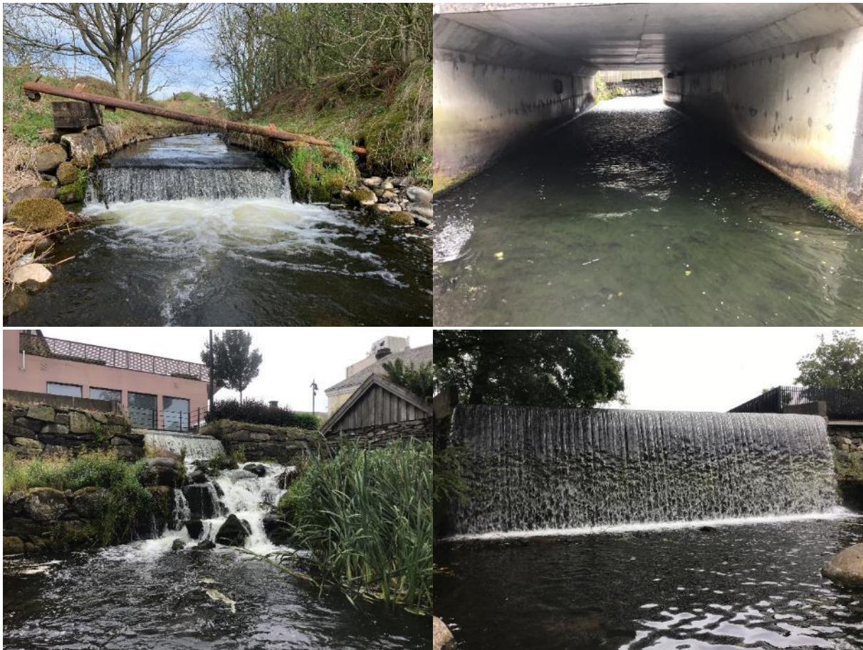
Figur 48. ØV: Vandringshinder 1, i sone 5. ØH: Vandringshinder 3, i sone 19. Bred kulvertbunn med lav vannsøyle og sterk strøm. NV: Vandringsstengsel 5, sone 19. NH: Vandringsstengsel 4 (Møllefossen), sone 19.
